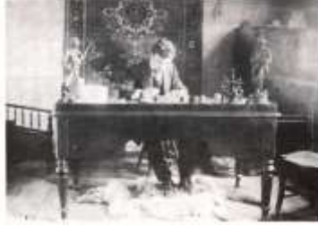
Dimitri Fillizis Trabzon'daki yazihanesinde çalışma esnasında
